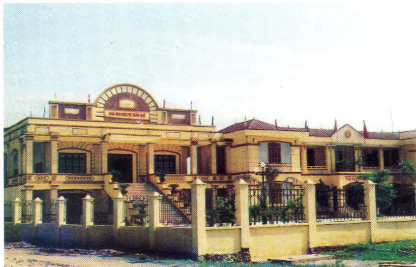
Trụ sở làm việc xây dựng năm 2001 và Nhà văn hóa Trung tâm Thị trấn Quốc xây dựng năm 2005.
